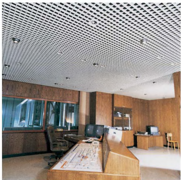
Control room: Kraftwerk Saarlouis
